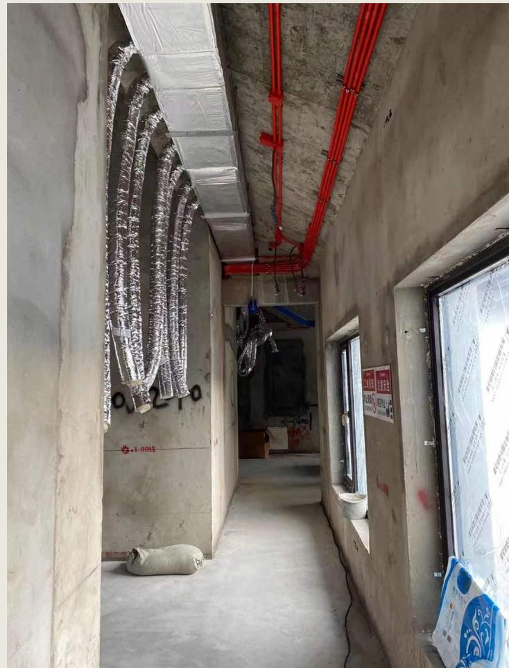
送风支管：全进口铝箔送风软管安装。
